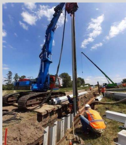
INBRENGEN PIPINGSCHERM
