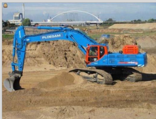
ONTGRAVINGEN MIDDELS HYDRAULISCHE GRAAFMACHINE
