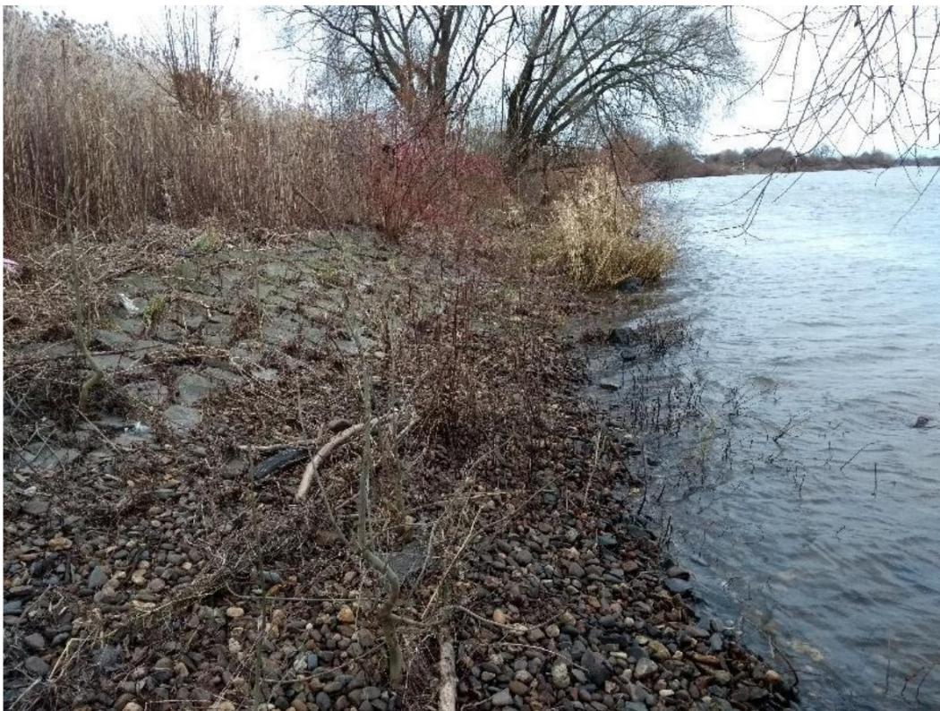
Foto 2. De meeste oevers langs dit deel van de Maas zijn voorzien van een stenen oeververdediging, bestaande uit een combinatie van grote en kleinere stenen.
